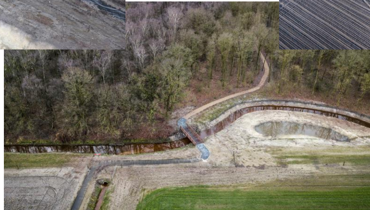
Werkzaamheden afgerond (februari 2018)
