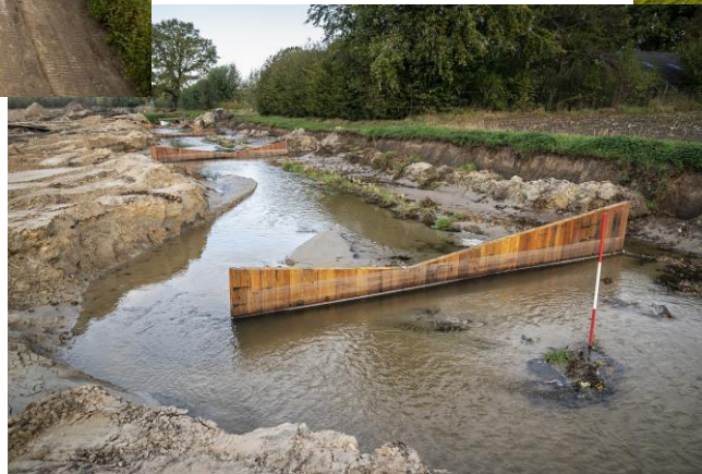
Aanleg cascade voor vissen (november 2020)
