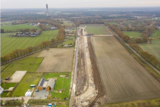
In uitvoering (november 2020)
