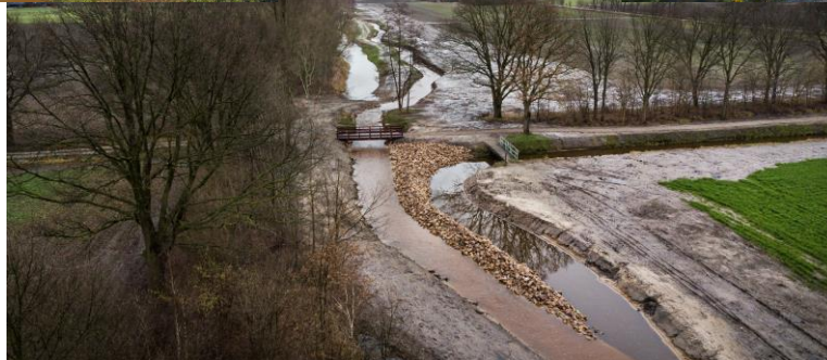
Werkzaamheden afgerond (februari 2018)
