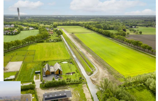
Werkzaamheden afgerond (mei 2021)
