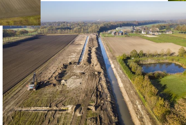
In uitvoering (november 2020)
