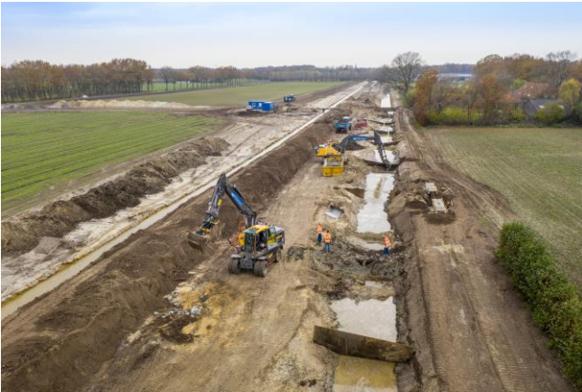
Aanleg cascade voor vissen (november 2020)
